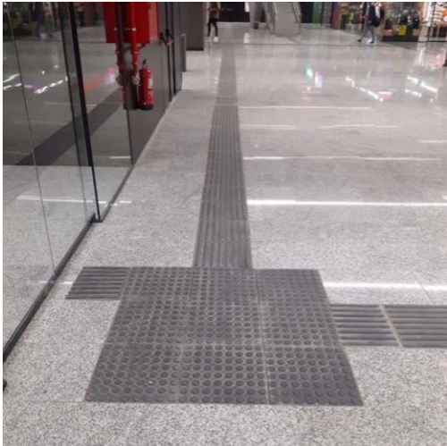
Camino podotáctil a todos los servicios de la estación.
